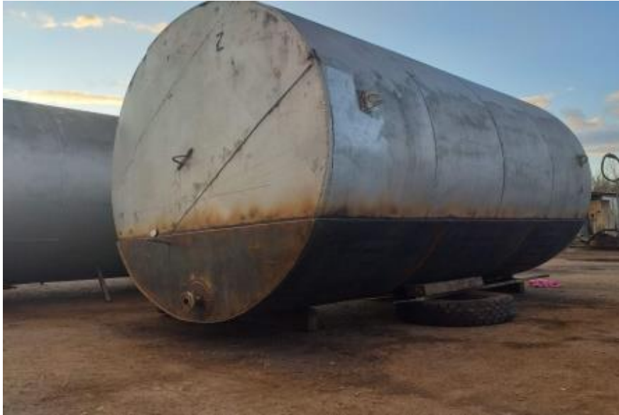
Рис. 4. Підсилення нижньої частини горизонтального резервуара
