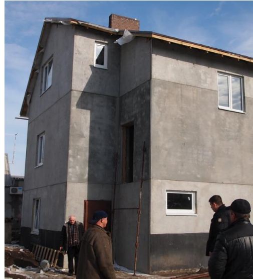
Рис. 19. Будівництво котеджу з тришарових панелей у м. Дніпро
