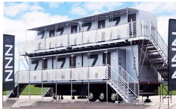
Рис. 9. Міні-готель «Snoozebox» із морських контейнерів, установлених на автомобільному шасі (Великобританія)
