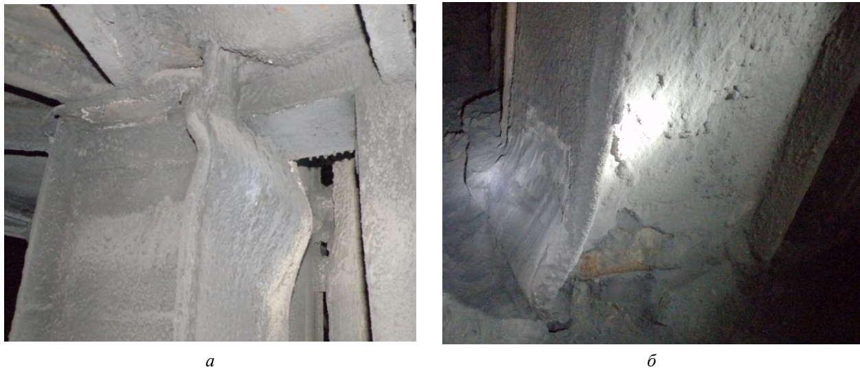
Рис. 6. Місцеве змінання стінки двотавра колони К2-прав на 60...80 мм на позначці +16.0
